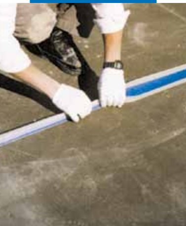
Exempel på vattentätning av expansionsfog på terrass
