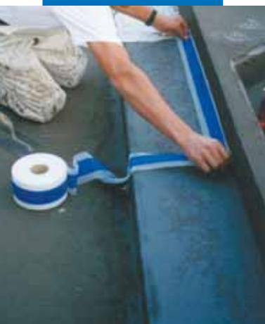
Exempel på vattentätning av vinkeln mellan botten och sidan på badkar med hjälp av Mapeband
